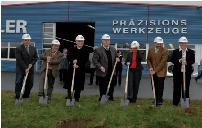
Spatenstich beim Erweiterungsbau der Miller GmbH in Altenstadt-Filzingen am 30.10.2007
